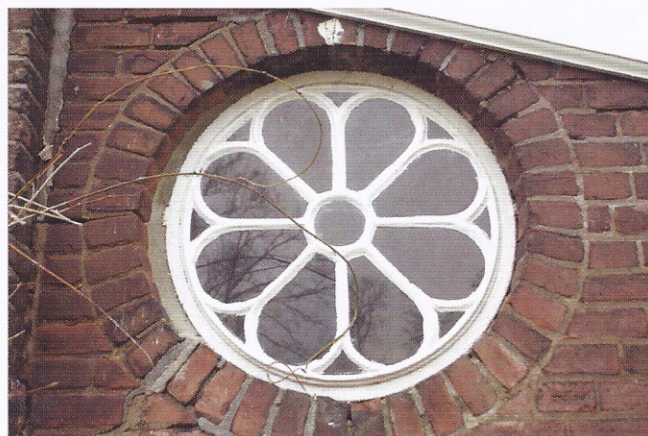
Gietijzeren raam in het koetshuis (foto: Han Uenk).
