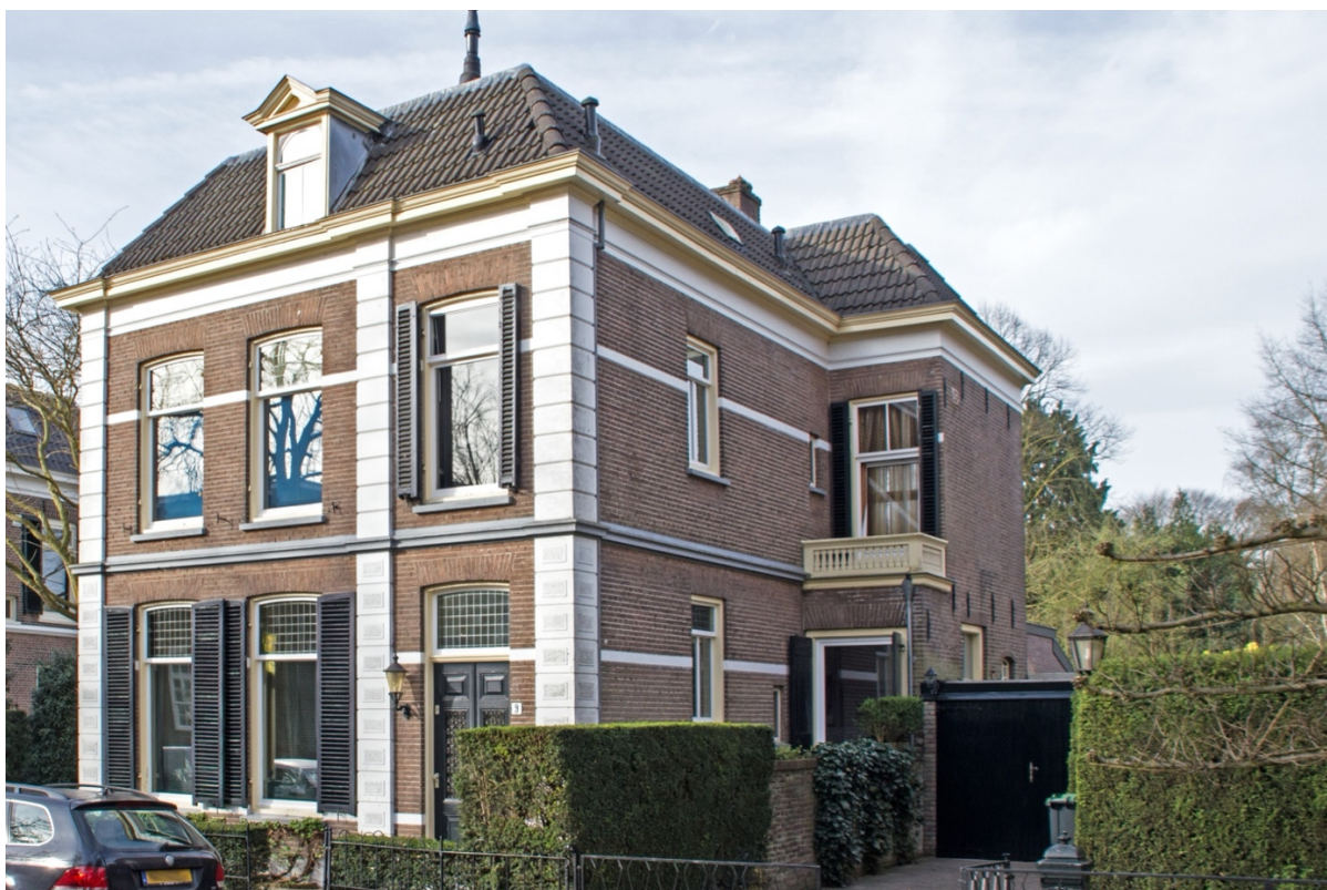
Voor- en rechterzijgevel – 2016.
