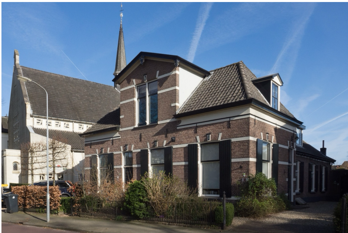
Voor- en rechterzijgevel – 2016.
