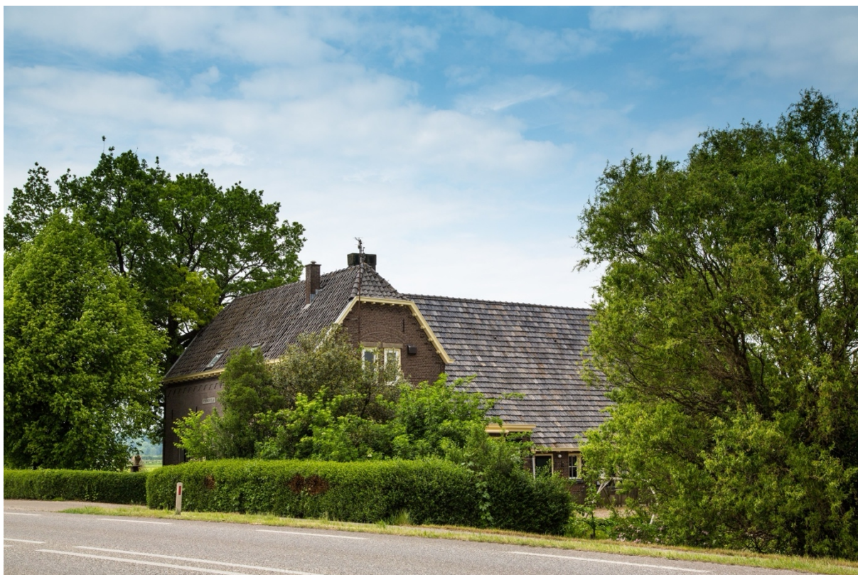
Voorgevel en rechterzijgevel
