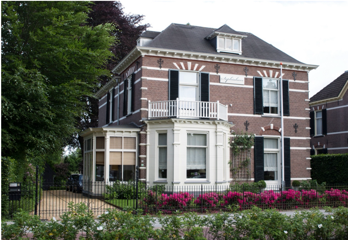
Voorgevel en linkerzijgevel - 2016 Foto: Fred Uittenbogaard / fotoclub Veluwezoom © CC BY-NC-ND
