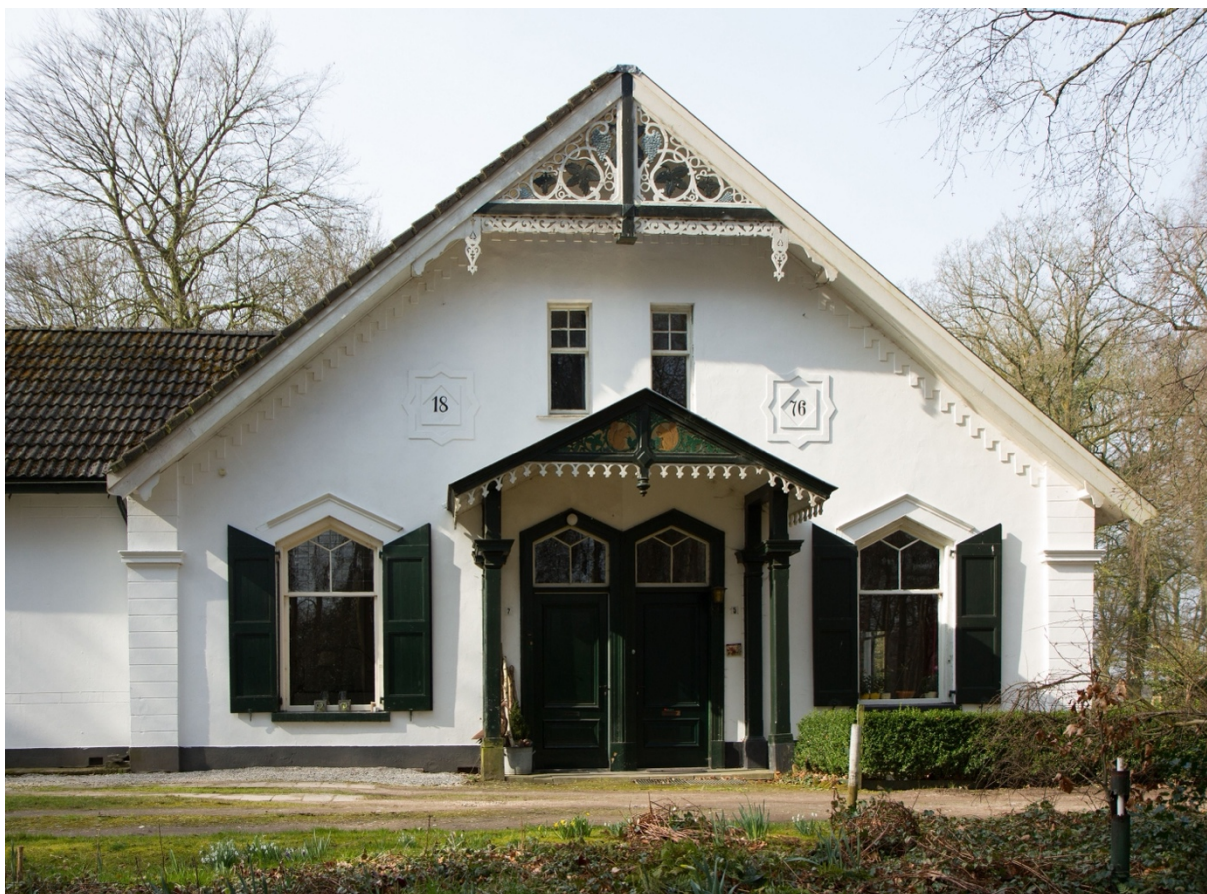
Voorgevel voormalig postkantoor en woonhuis – 2016.
