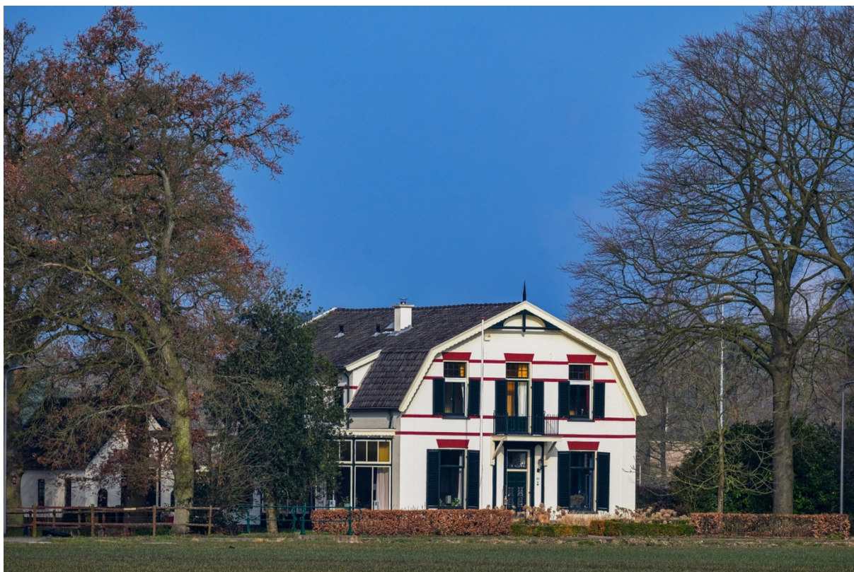
Voorgevel Voormalig pension Gerbrandts – 2016.
