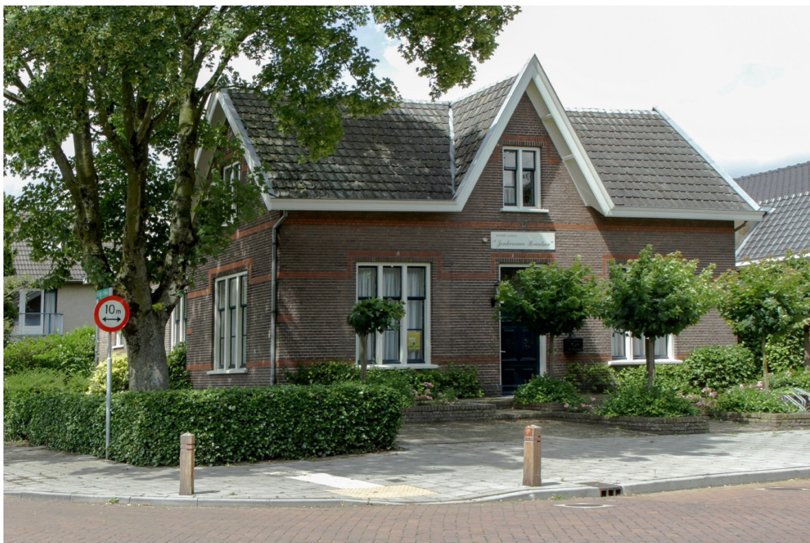
Voorgevel en linkerzijgevel Jonkvrouwe Brantsenschool - 2016
