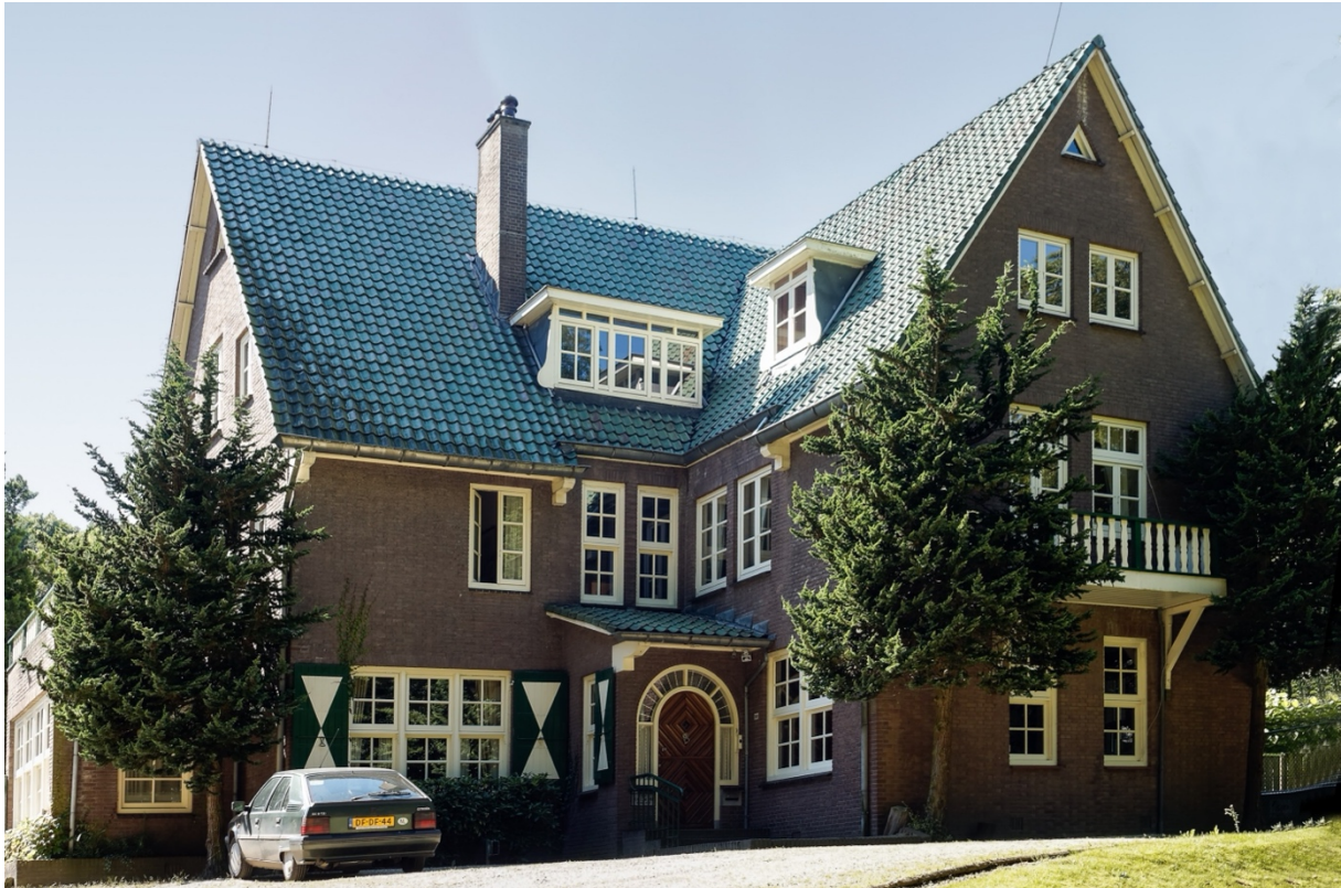
Voorgevel en linkerzijgevel – 2016
