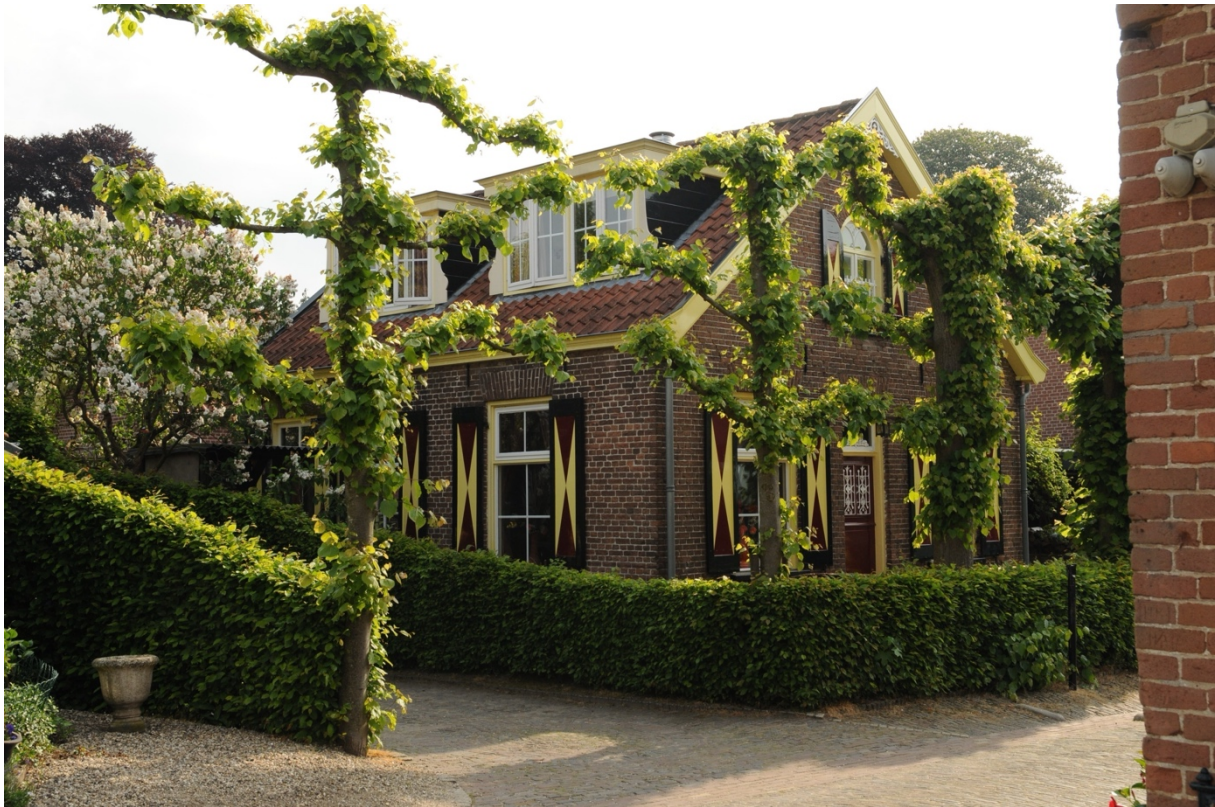
Voor en linkerzijgevel – 2016
