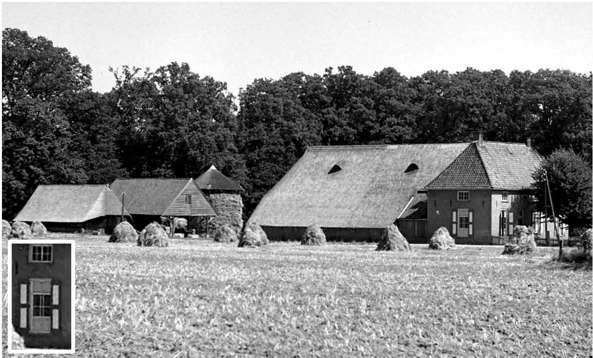
De Wolfskuil omstreeks 1930, Nederlandse Heidemij. (NA 2.24.06.02, inv. nr. 164-0731). Kort na deze foto zou de hooiberg verdwijnen. De (wellicht gietijzeren) ramen van het woonhuis uit 1863-'64 (inzet) hebben nog hun oorspronkelijke hoogte en roedenverdeling en zijn voorzien van luiken.
