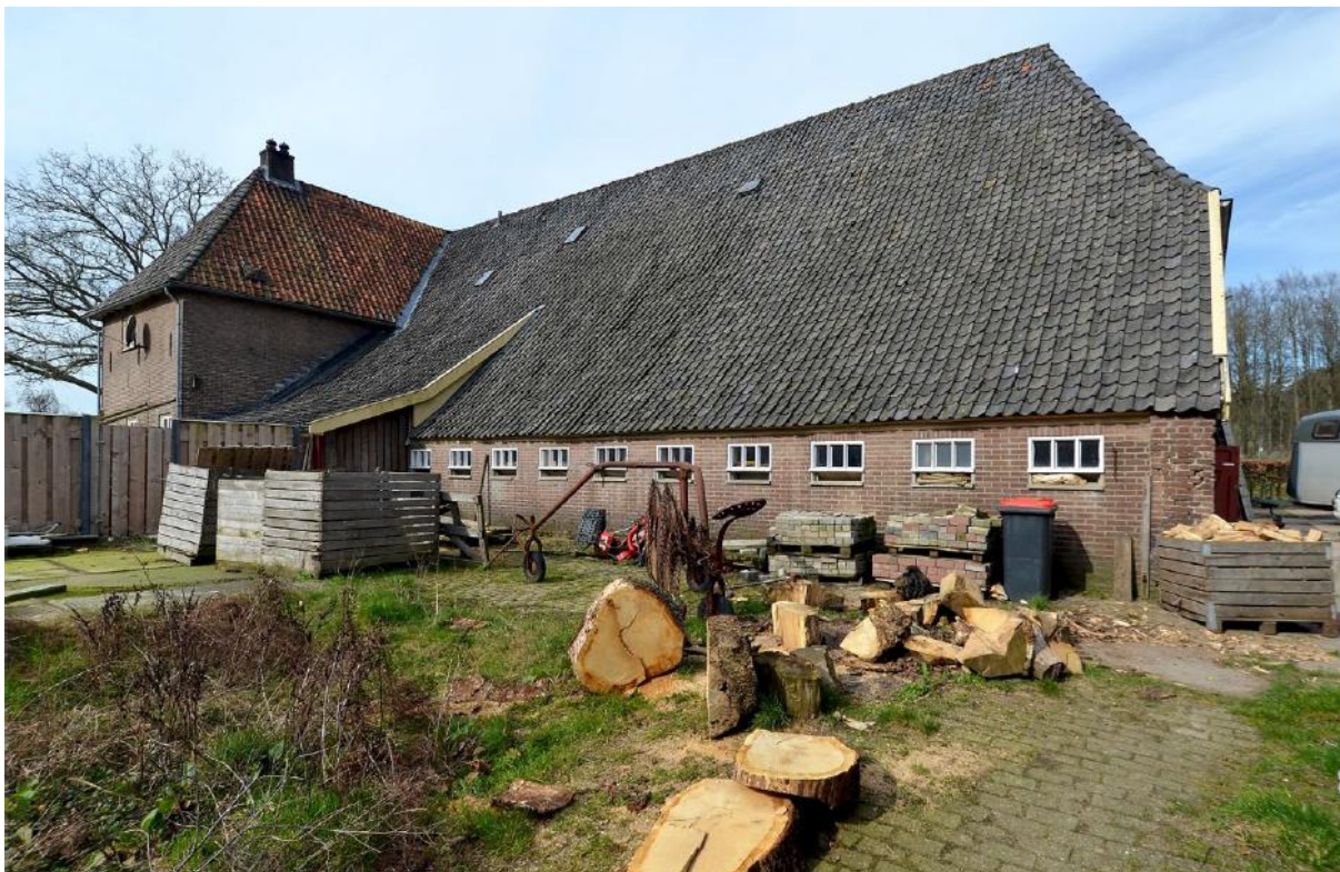
Rechterzijgevel, begin 2023. Foto De Fabryck.
