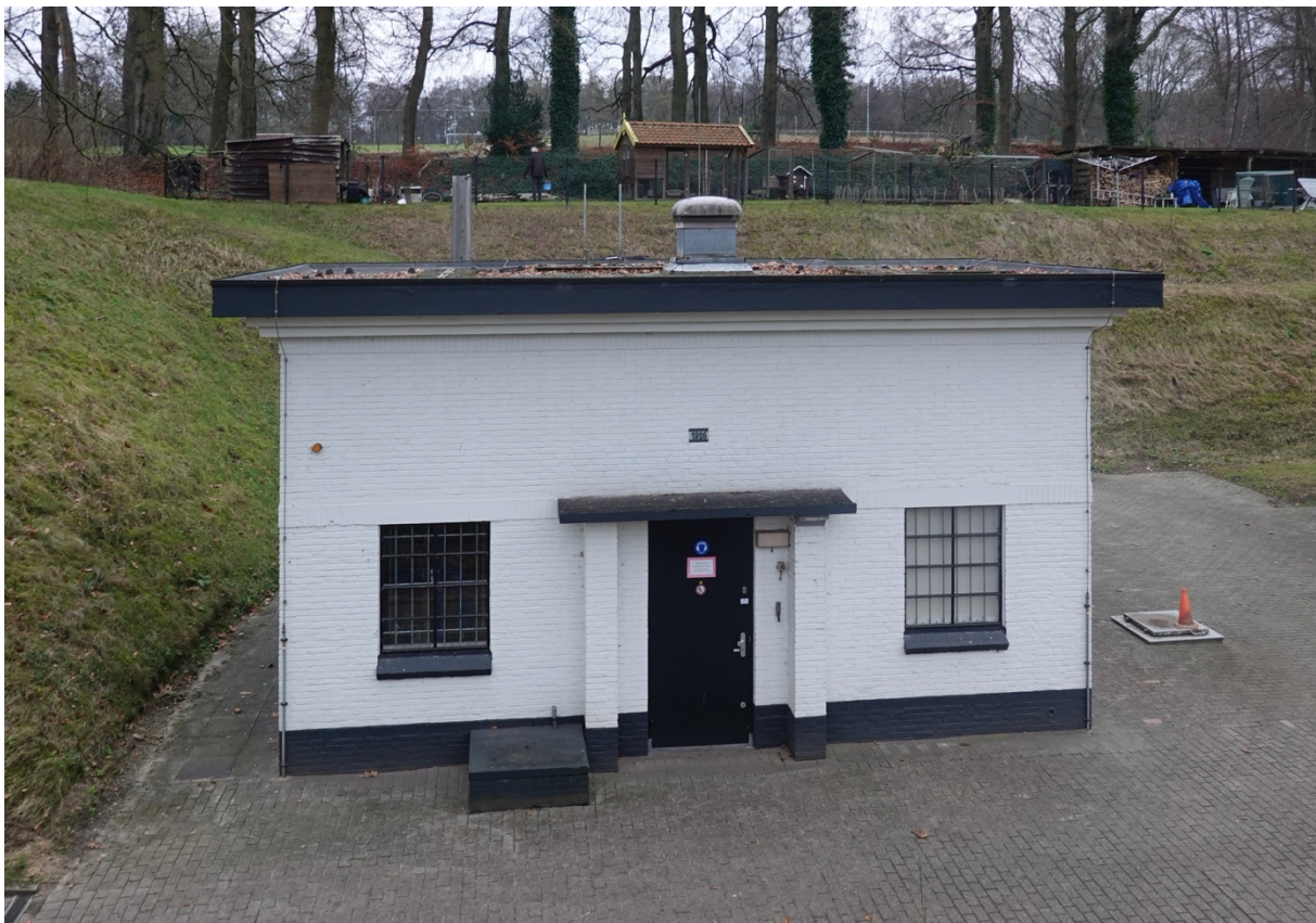
Waterpompstation en berging, nu fingerend als noodstroomstation (2025) Foto: HenkvD © CC BY-SA 4.0
