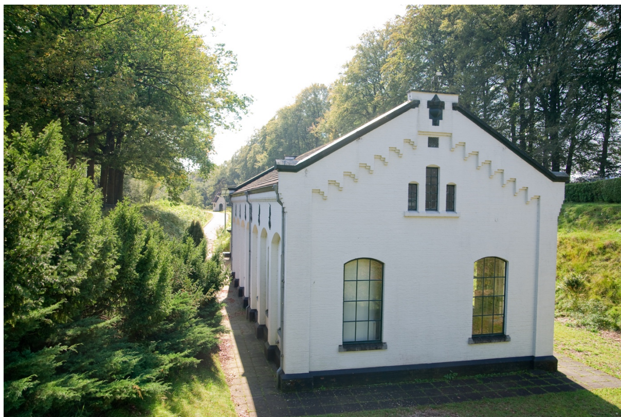
Eenlaags waterpompstation onder flauw hellend zadeldak
