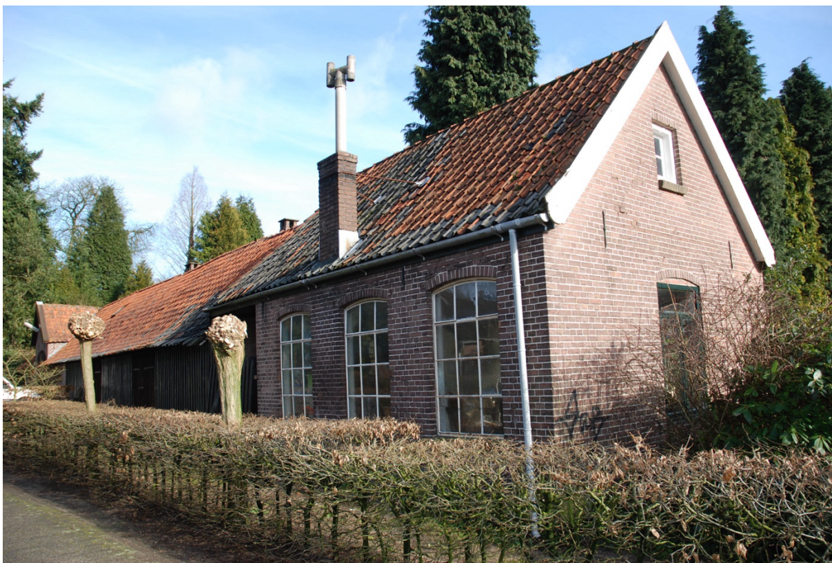
Zeerbreed, ondiep bedrijfsgebouw (2014)
