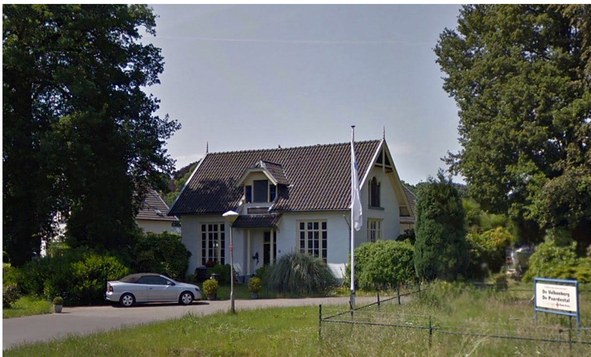
Portierswoning De Valkenberg te Rheden
